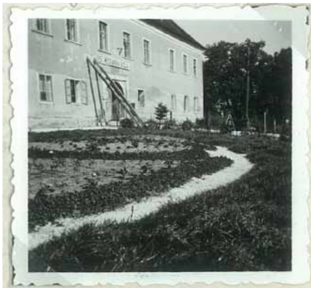
Budova Meštianskej školy v kaštieli podpretá drevenými trámami
